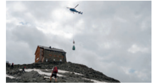
Hochstubaiahütte mit Heliversorgung
